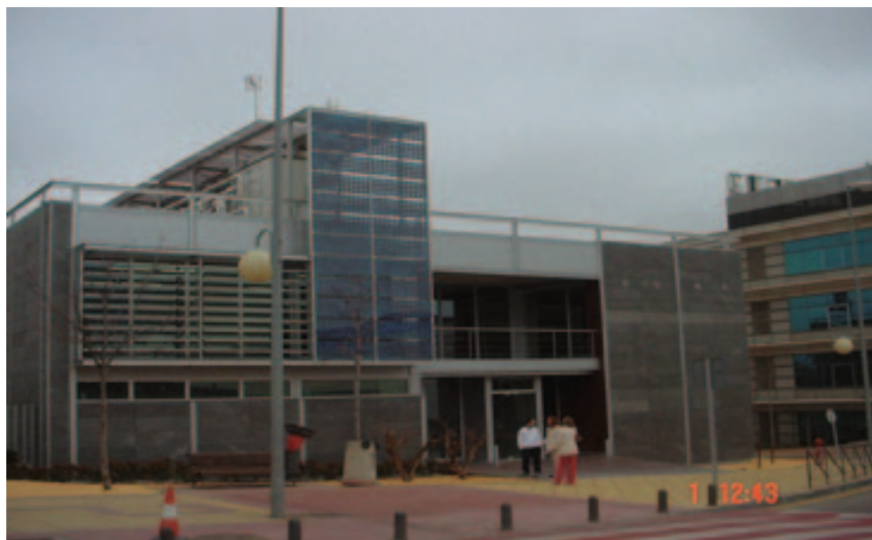
Foto 6. Instalación fotovoltaica integrada en muro cortina.
