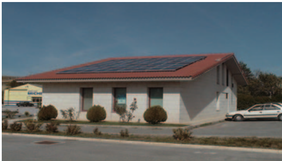
Foto 3. Sistema fotovoltaico sobre tejado inclinado.
