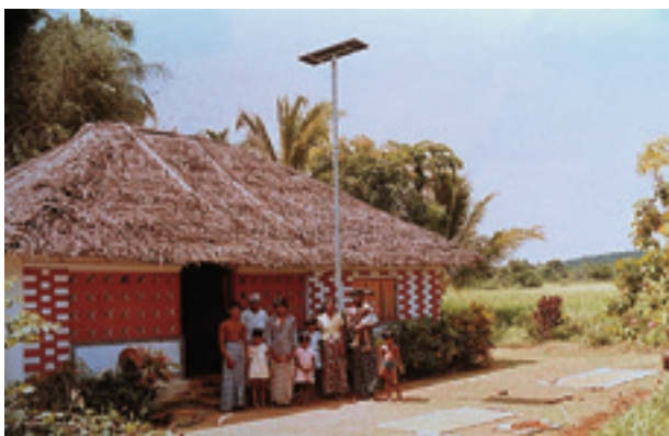
Foto 1. Instalación fotovoltaica aislada.
