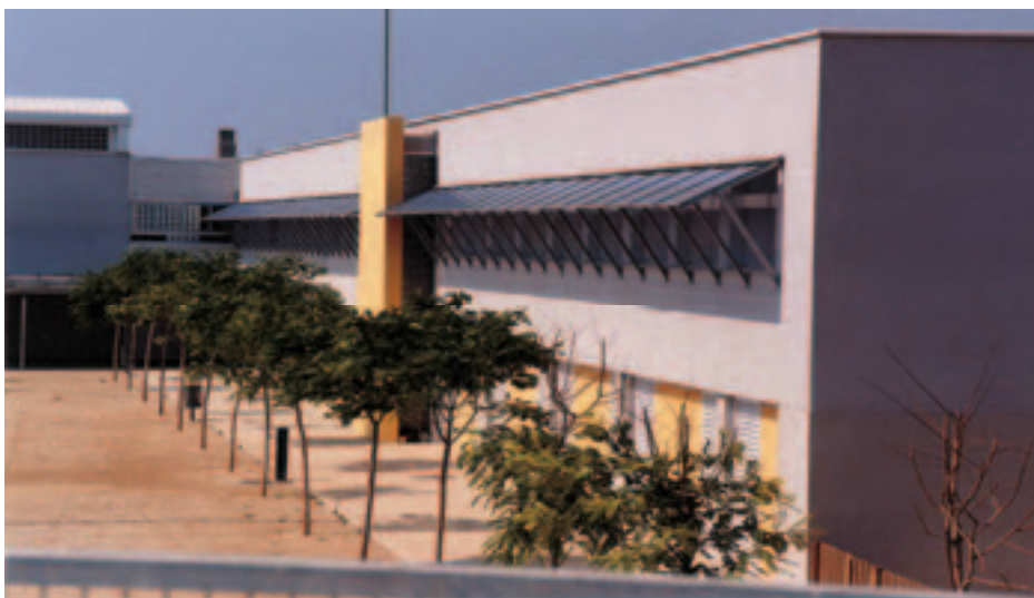
Foto 9. Instalación fotovoltaica integrada en parasoles.
